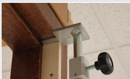
Afb. 6 Bovenzijde Deurtelescoop in kozijn
